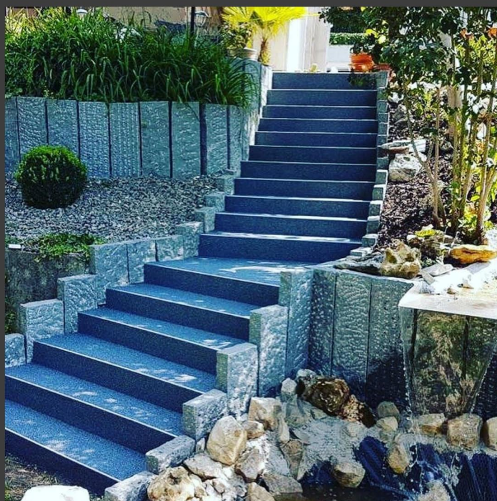
Betontreppe abgedichtet, und mit einem Stein- teppich verkleidet
