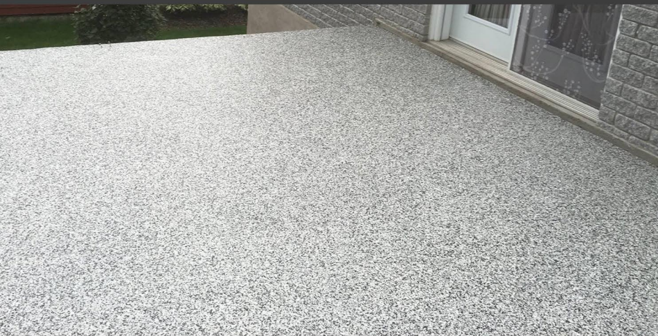
Abdichtung auf einer Terrasse, versiegelt mit einem Flakesystem und PU Versiegelung
