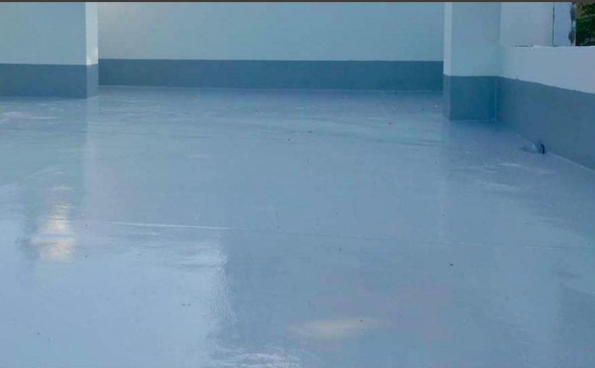
Abdichtung auf einer Terrasse, versiegelt mit einem Flakesystem und PU Versiegelung
